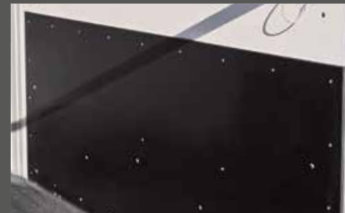
Trapbescherming aan de zijwanden
